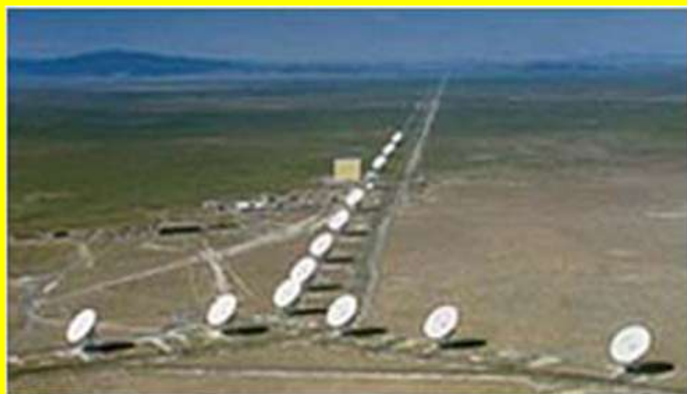
Interferometar u Novom Meksiku (dužina "krsta" 30 km sa 27 radio-antena)
